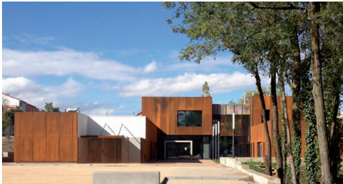
Δ Maison de quartier / St Genis-laval (69) / STUDIO PYC
